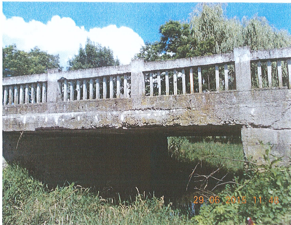
FOTO 3. ZONE CU BETON EXFOLIAT SI ALBIE PARTIA COLMATATA
